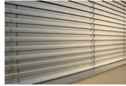
lamel w kształcie Z szerokość lameli 90 mm
