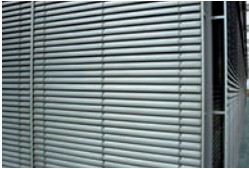
lamel w kształcie C szerokość lameli 80 mm
